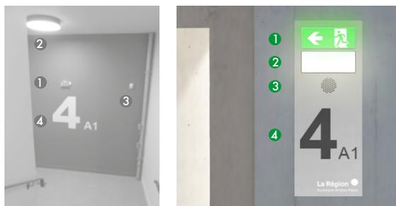
Exemple d'intégration multifonctionnelle 4 en 1 dans une cage d'escaliers (éclairage de sécurité, applique d'éclairage, détecteur de présence, signalétique d'étage).
