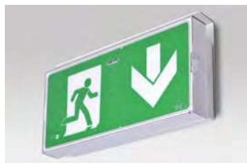
POSE PLAFOND EN DRAPEAU
