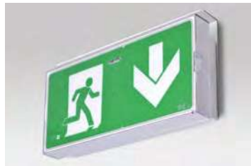
POSE PLAFOND EN DRAPEAU
